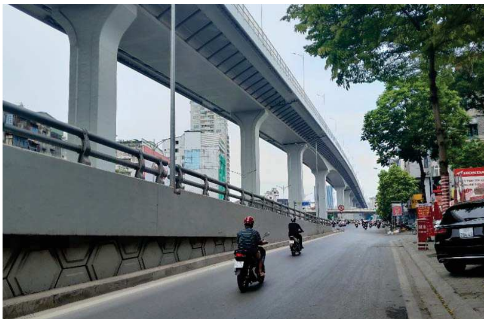
Rysunek 3. Przykład poprowadzenia linii kolei naziemnej estakadą ruchu przelotowego tunelem z bocznymi pasami dojazdowymi w Hanoi (wykonano 05.06.2023 r.)
