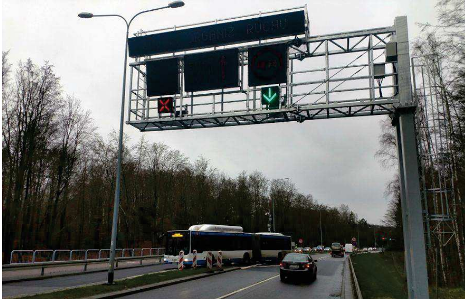
Figure 4. Markings for a dynamic bus lane Ryc. 4. Oznaczenia dynamicznego pasa dla autobusów Source: [Ruciński n.d.].
