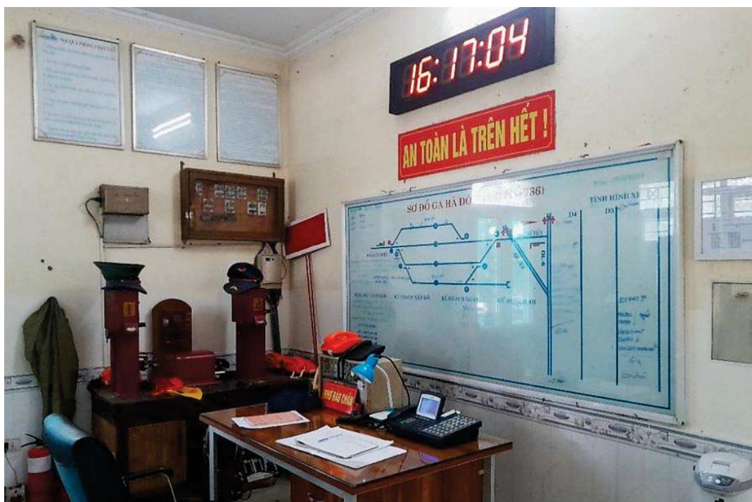
Rysunek 13. Nastawnia dysponująca stacji Ga Phú Diễn na tzw. towarowej obwodnicy Hanoi z widocznymi archaicznymi urządzeniami berłowymi (wykonane 03.06.2023 r.)
