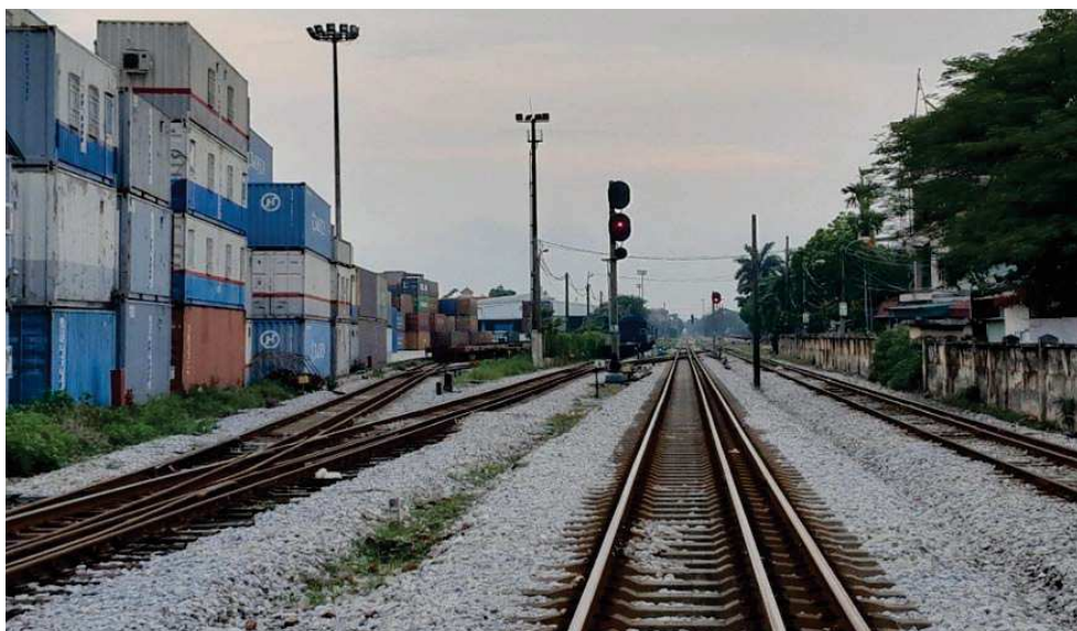
Rysunek 10. Stacja Yên Viên na wschód od Hanoi z położonym w jej obrębie terminalem kontenerowym obsługuje pociągi dwu szerokości toru – 1000 i 1435 mm (wykonane 06.06.2023 r.)
