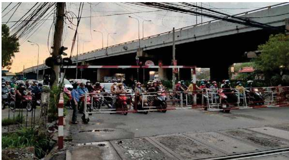
Rysunek 5. Przykład udanej separacji ruchu: pojazdy ciężarowe i ruchu tranzytowego kierowany wiaduktem, ruch lokalny przez skrzyżowanie jednopoziomowe z rogatkami uruchamianymi ręcznie przez dwu droźników; obrzeża Ho Chi Minh City (wykonano 24.05.2023 r.)
